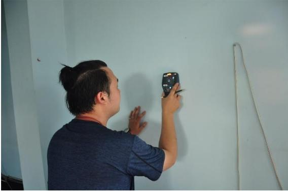
圖 1.2.14 以手持鋼筋掃描儀針對牆體進行掃描
