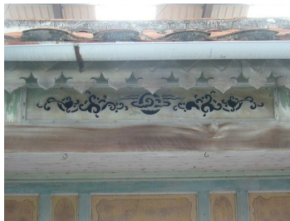
【圖 4-9-25】一進明間之簷廊欄間，以日雲為中心
