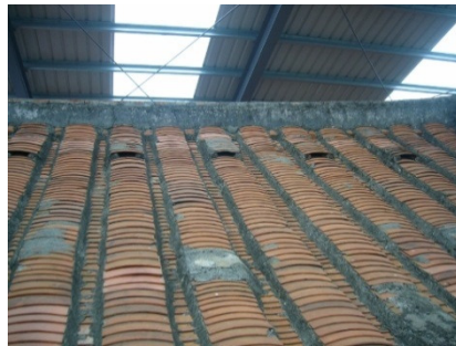
【圖 4-7-68】屋頂瓦隴可見設有通氣孔
