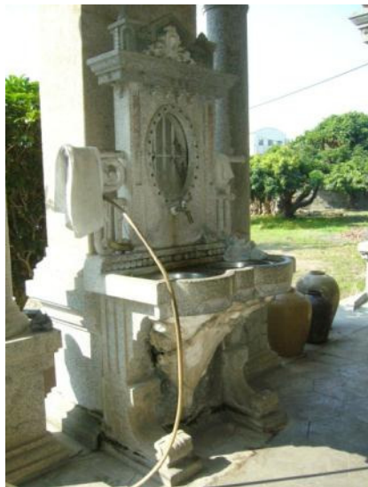
【圖 4-10- 3】精緻的洗石子洗面台
