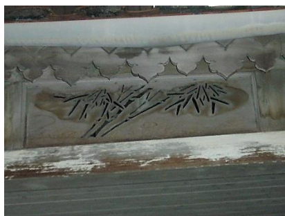
【圖 4-9-37】二進次間簷廊下的欄間，簷廊下的青竹樣式
