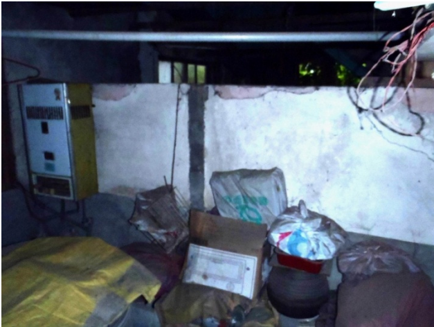
【圖 4-8-15】早期的衛浴空間，現堆積雜物
