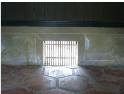
【圖 4-7-73】左右廂房牆體下方設有長 47cm 高 38cm 的通氣孔
