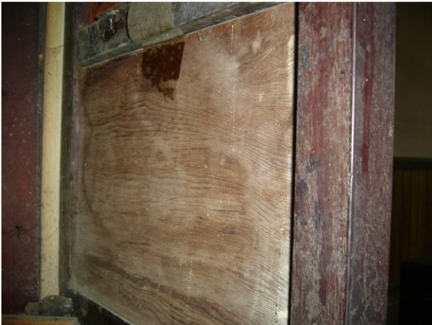
【圖 4-9-21】玻璃彩繪背後以板材封住保護
