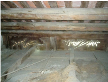
【圖 4-7-70】屋頂木結構、天花板與鏤空木雕現況
