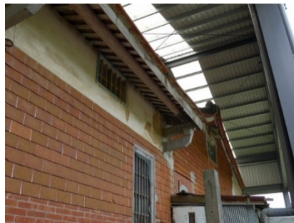
【圖 4-7-71】外牆可見設置增加室內天花板通風及二樓採光通風之窗扇
