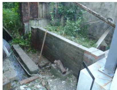
【圖 4-8-8】左側原有的豬舍和廁所
