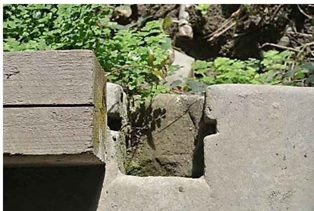
【圖 4-8-11】原有屋頂柱樁
