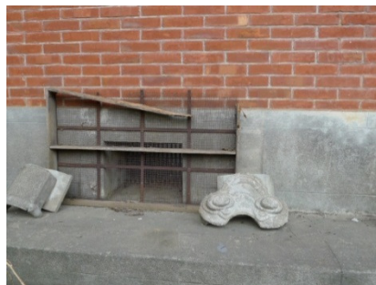
【圖 4-7-74】右廂房通氣孔外側設置鐵網防止動物進入室內
