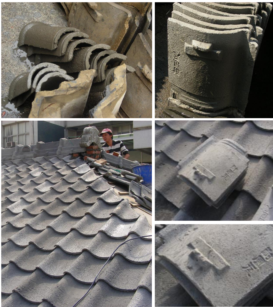
【相 7-4.2】日式建築舊瓦表面塗覆水泥砂漿
