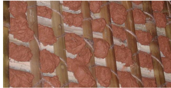
【相 7-4.7】竹材防腐（左）與編竹夾泥牆底層泥料塗覆
