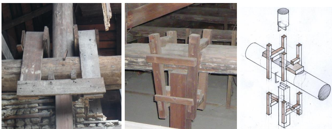
(2) 日治時期木造官舍之吊架實例：宜蘭化龍一村(左)與央廣民雄日式宿舍群
