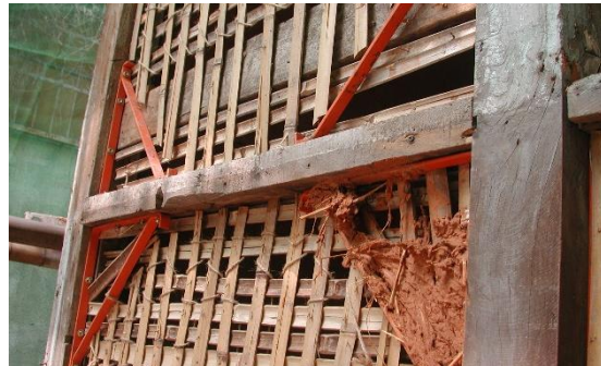
【相 7-4.9】木柱與貫木節點以鐵件補強
