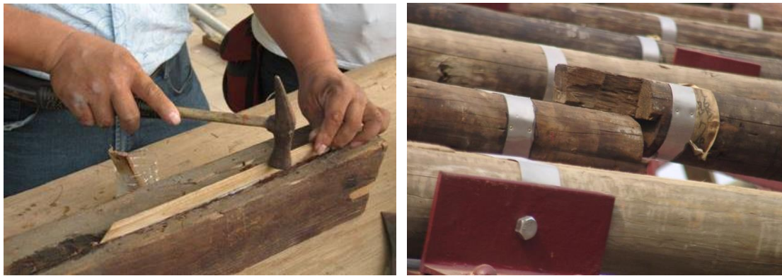
【相 7-4.5】木構件包覆鐵片（右）以及縫隙填補同材質木料
