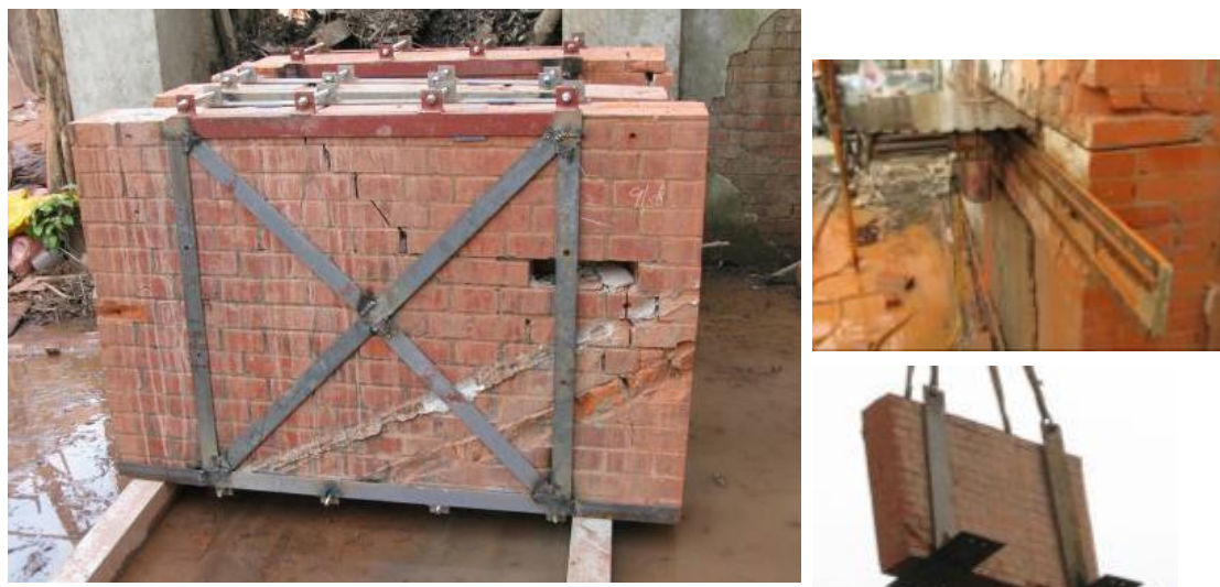
磚牆切割與吊運（以鋼帶鉸包覆加固）
