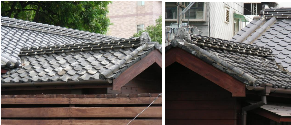
【相 7-4.1】日式建築舊瓦重鋪與新瓦集中鋪設
