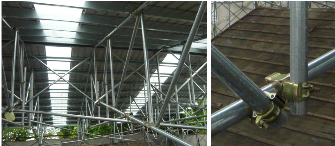
【圖 7-4.19】以鷹架鋼管搭設之防護棚架（臺南市歷史建築安溪國小辦公室修復工程）
