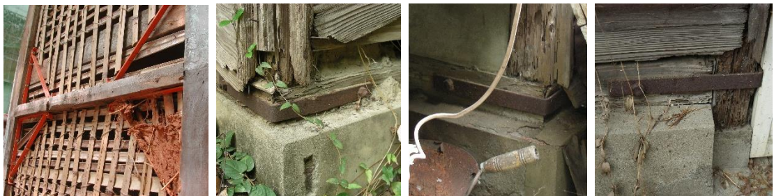
(3) 左：彰化武德殿附屬建築 / 右：1935年地震後日式木造官舍補強實例（臺中市歷史建築潭子國小校舍）
