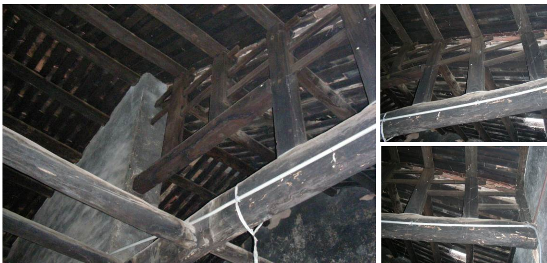
劉秀才屋正堂右梢間屋架型式較為完整（屋架形式應受日式和小屋組影響）
