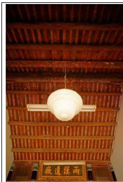
【圖 3-2.12】劉秀才屋廳下面內 11 架楹擱檁式構架
