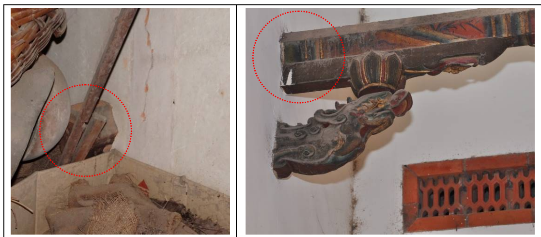
【圖 3-2.23】劉秀才屋燈樑為六角形，下方設有雞舌及斗拱雕刻裝飾，作法精緻（右）；燈樑凸出左右兩側壁面，亦遵循「出丁」規範（左）。
