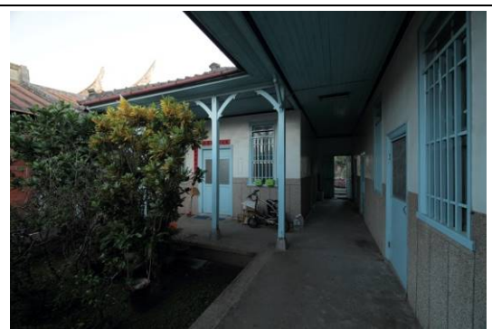
【圖 3-2.5】龍邊（左邊）左二橫屋連接過水採日式作法，屋頂為日式水泥瓦形式。
