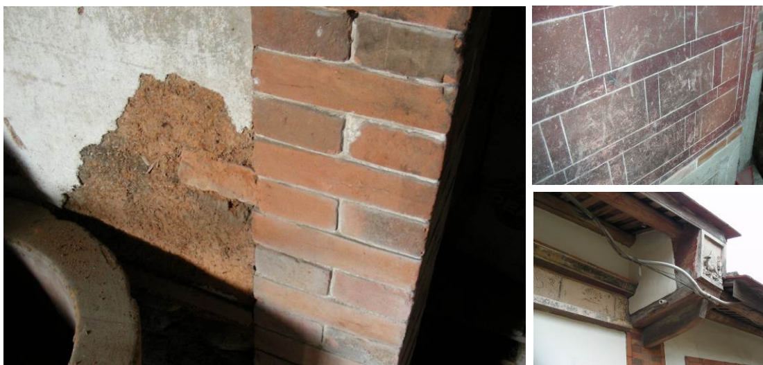
開口部磚柱交丁磚材、內側水泥砂漿仿斗砌紋路以及出挑牆體下方以木板支撐（磚材尺寸約 4cmx11cmx22.5cm）
