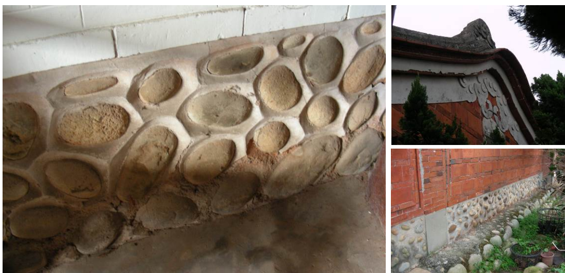
卵石基座灰泥與規帶細部做法（卵石短徑約 10cm 至 15cm、長徑約 12cm 至 30cm）
