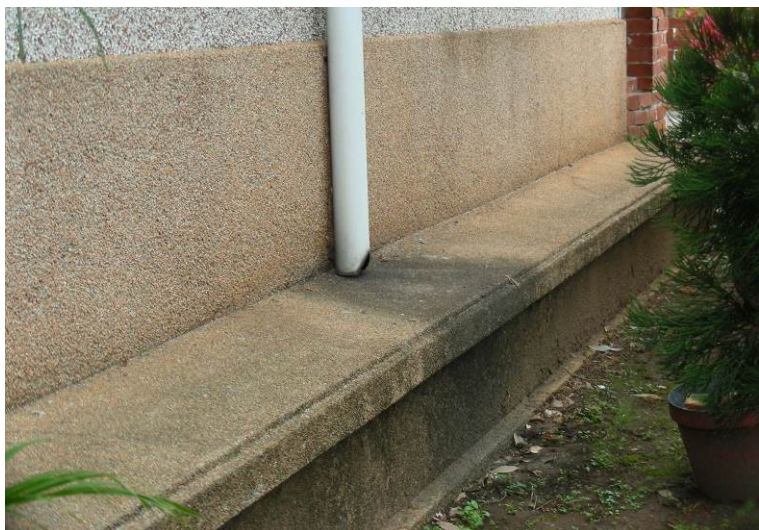
劉秀才屋左二橫屋磚牆基座與簷柱柱礎
