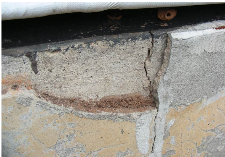
劉秀才屋左二橫屋編竹夾泥牆勒腳牆為混凝土構造
