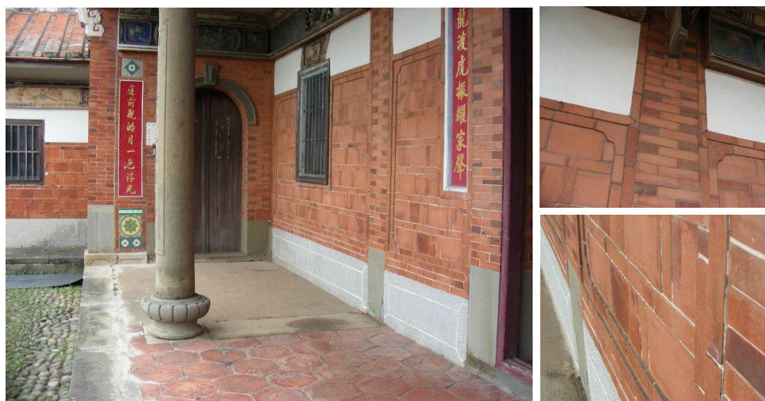
劉秀才屋正立面牆體大致可分為卵石基座、斗砌牆面與土塼構造三段
