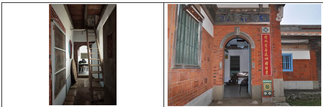
【相 3-1.11】內廊與房間有隔間牆
