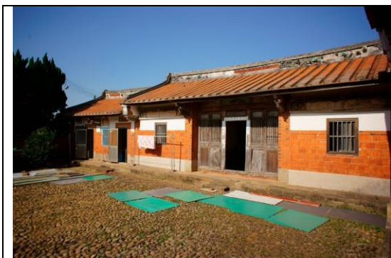
【圖 3-2.6】虎邊（右邊）左一橫屋為傳統漢式作法，屋頂為棟頭形式。
