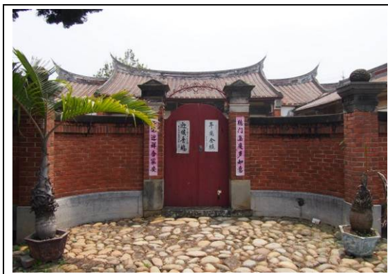
【相 3-1.73】內埕牆頭現況
