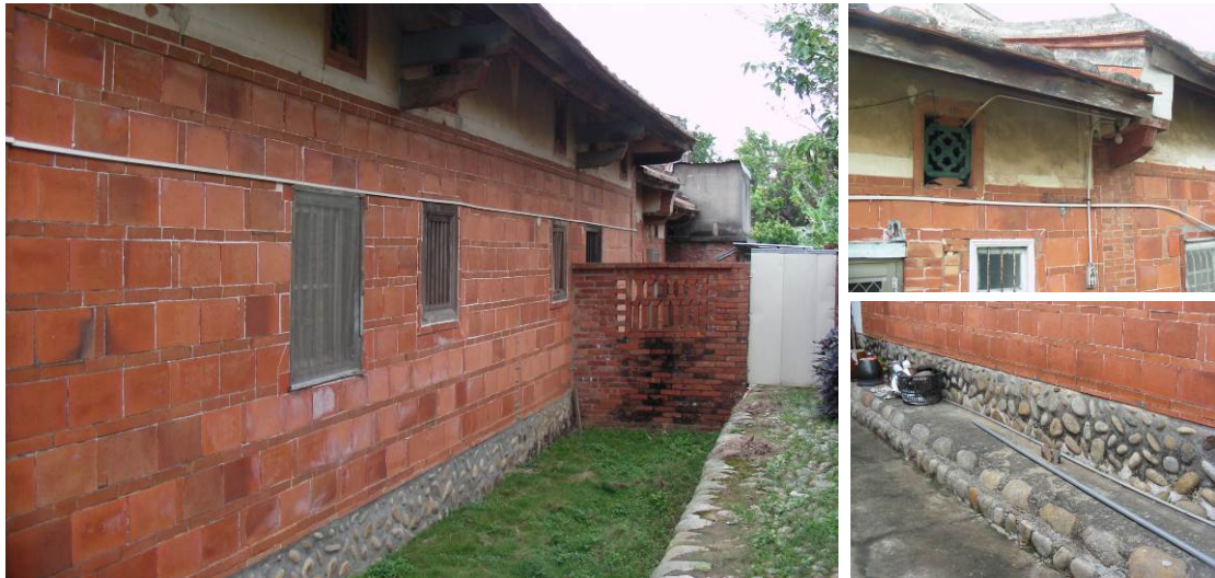
劉秀才屋背牆同樣分為三段構造（尺磚厚度約 3.5cm、寬度約 15cm、長度約 27cm）
