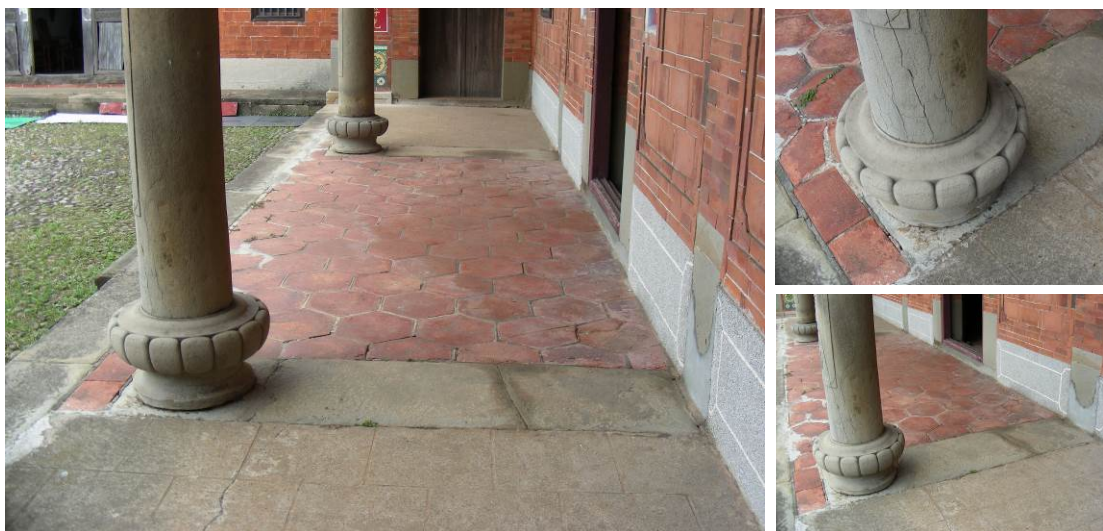
劉秀才屋正堂步口明間鋪設六角磚以及其他鋪設水泥砂漿之鋪面（兩者之間以石板為區隔）
