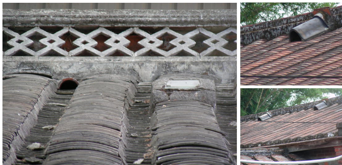
清水瀞園外橫屋屋脊（左）以及新埔西河堂左外橫屋屋脊設置之通氣孔
