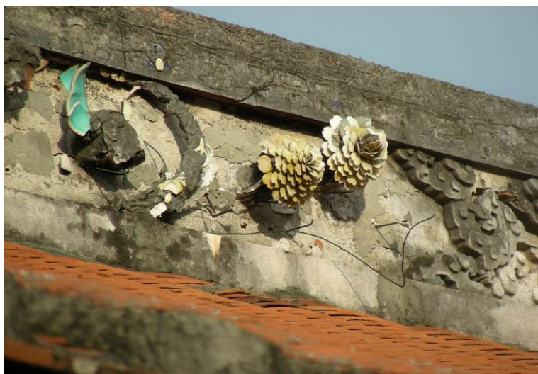
劉秀才屋屋脊剪黏多處已損壞
