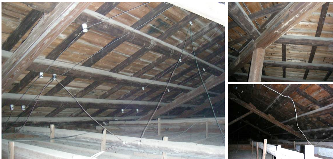
劉秀才屋左二橫屋屋面構造與同時同類型建築相同（防水層為油毛氈）
