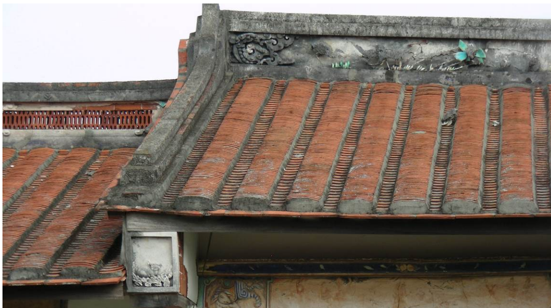
劉秀才屋橫屋同樣鋪設仰合瓦（合瓦鋪設密度明顯較仰瓦大）
