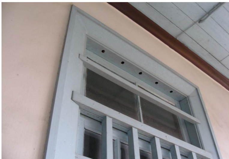
劉秀才屋左二橫屋磚牆窗扇與編竹夾泥牆之出格子窗
