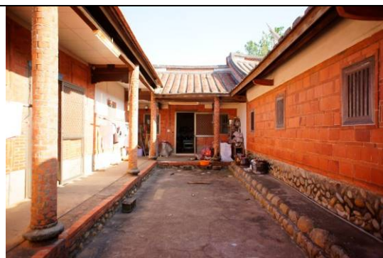
【圖 3-2.7】虎邊（右邊）左二橫屋為傳統漢式作法，屋頂為棟頭形式。
