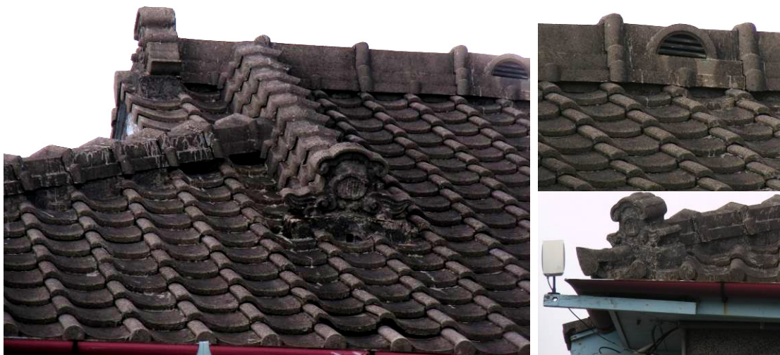
劉秀才屋左二橫屋屋頂鋪設和瓦樣式之水泥瓦（脊瓦側面有通氣孔）
