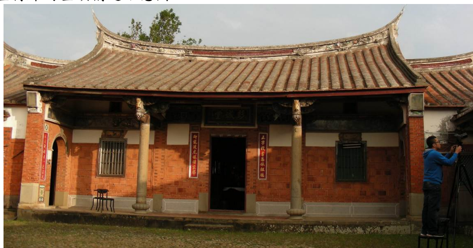
劉秀才屋正堂屋頂鋪設仰合瓦
