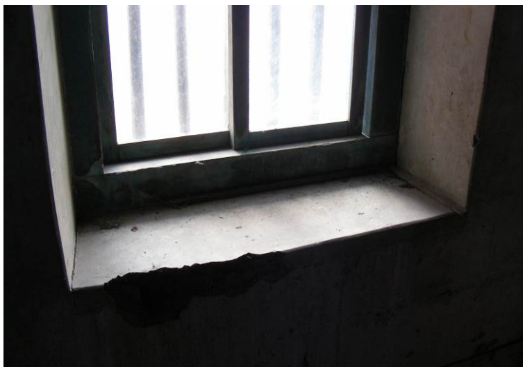
劉秀才屋外牆開口內寬外窄（正堂步口以拱門通往梢間）
