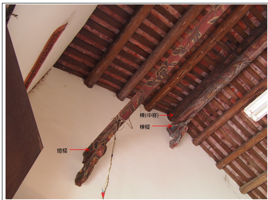
【圖 3-2.19】劉秀才屋廳下空間中脊處設有雙樑，上方為「棟」（中脊）、下方「棟樑」。
