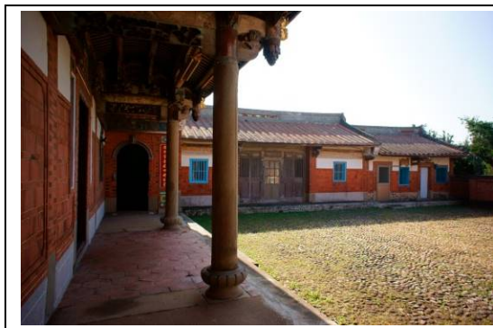
【圖 3-2.4】龍邊（左邊）左一橫屋為傳統漢式作法，屋頂為棟頭形式。
