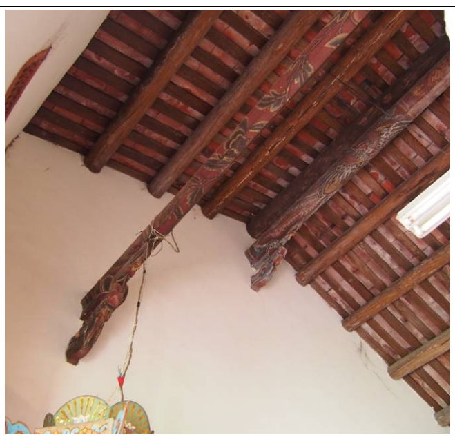
【圖 3-2.12】劉秀才屋廳下面內 11 架楹擱檁式構架
