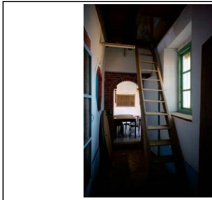
【相 3-1.59】廳下右側房間的棚頂，出入口設置於內廊道
