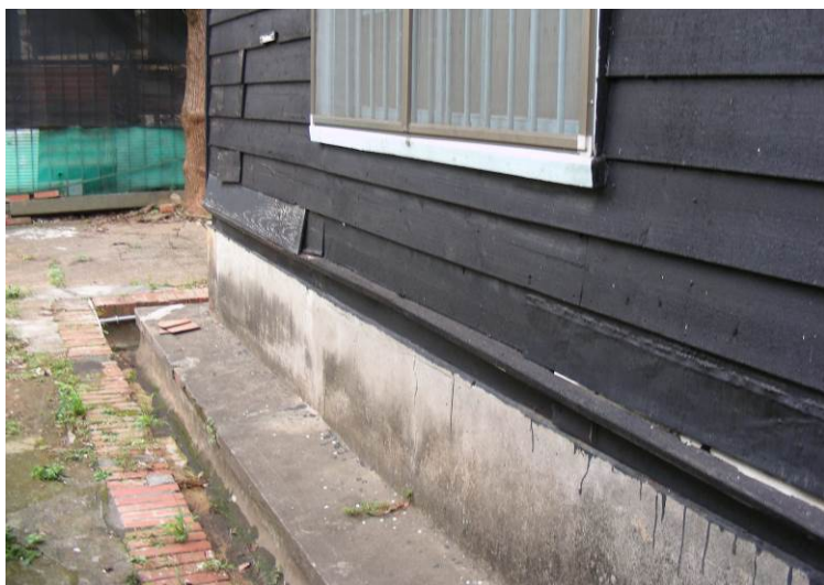
劉秀才屋左二橫屋外牆編竹夾泥牆外覆雨淋板
