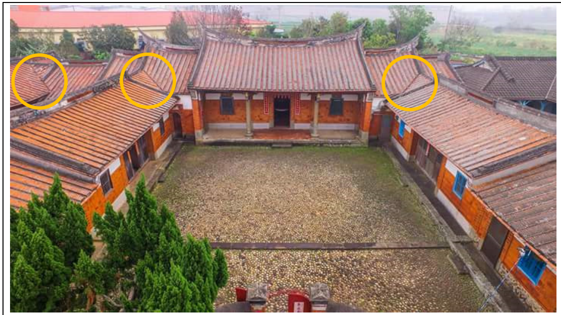
【圖 3-1.33】劉秀才屋屋面轉溝位置示意圖
