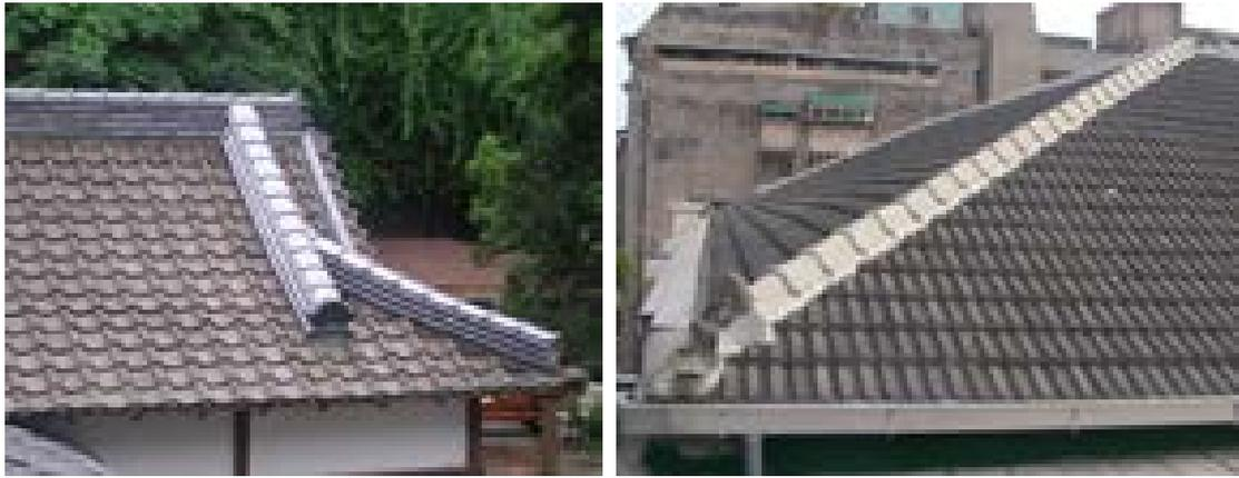
圖 7-2 舊瓦重鋪與新瓦集中鋪設實例
