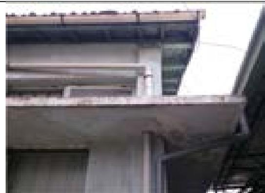
照片 4 雨庇緊靠鄰房屋頂，下方粉刷層浮凸
