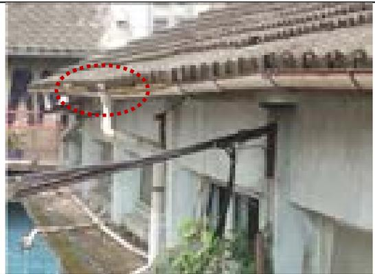
照片 6 北坡簷口波浪狀變形·天溝落水口阻塞
