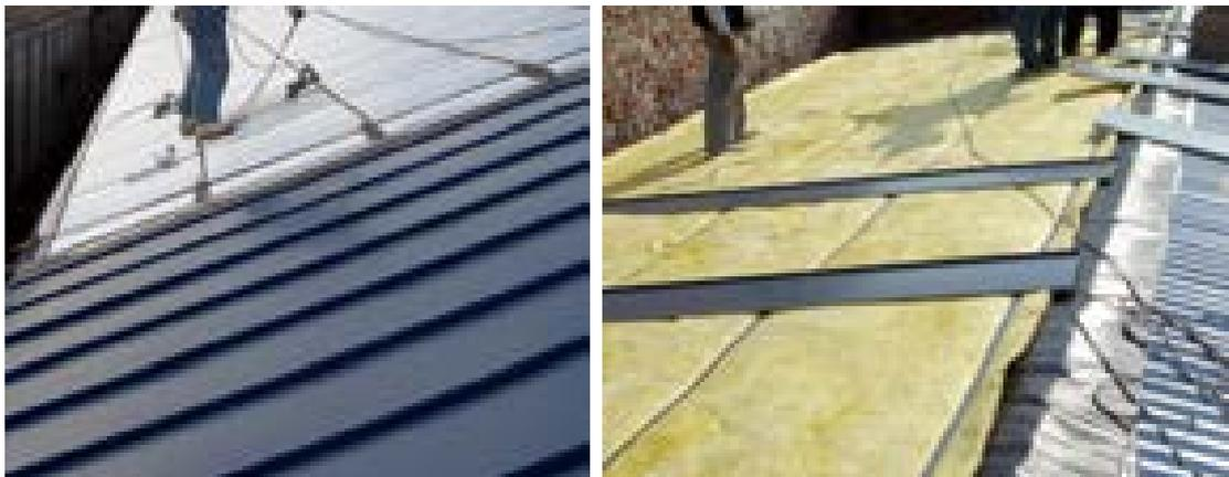
圖 7-7 金屬材質屋瓦及搭配使用之隔熱材料
