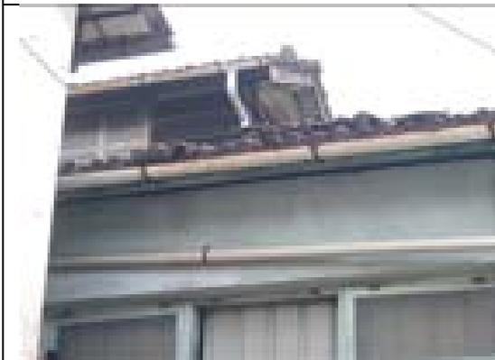
照片 7 北坡西側簷口瓦脫落
