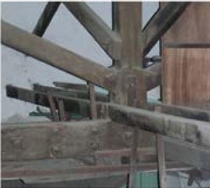
正同柱下方之結點構造 ( 另有剪刀撐及水平夾撐 )
