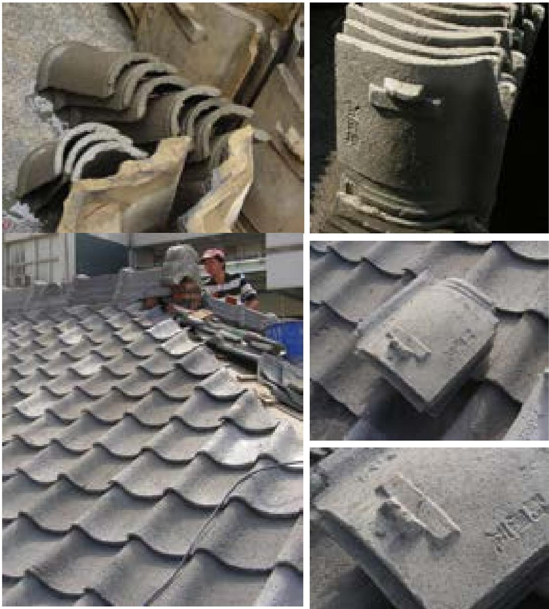
圖 7-3 水泥舊瓦表面塗覆水泥砂漿
