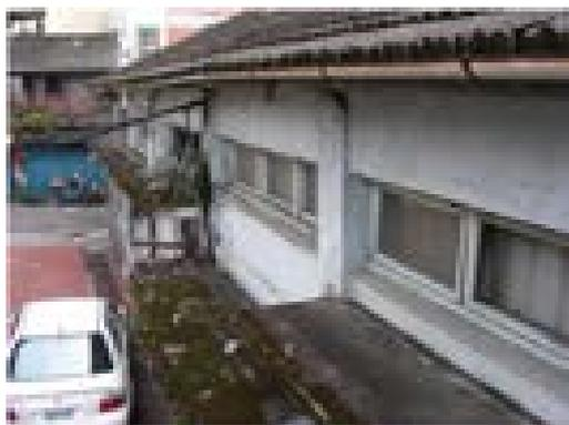
第四市場氣窗構造使鋼筋混凝土柱形成短柱
