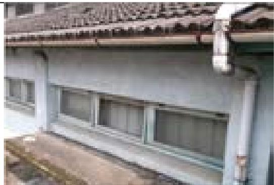
照片 2 落水管塑膠管劣化
