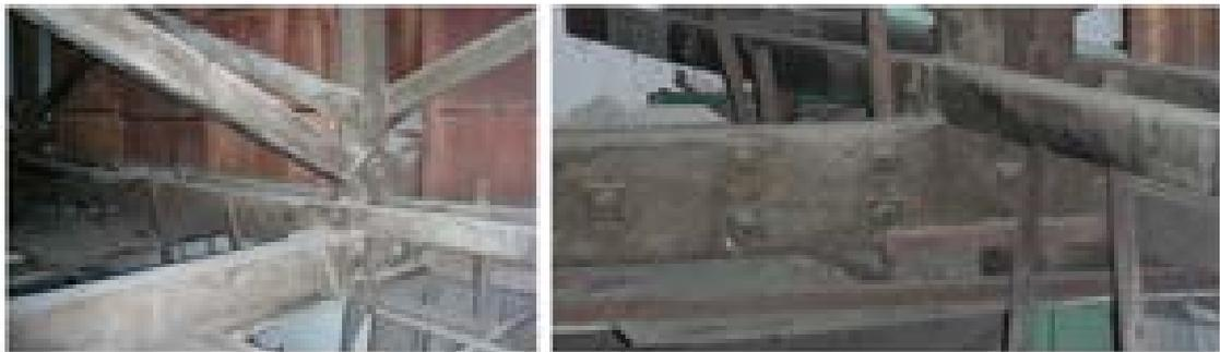
圖 3-20 台中市第四市場屋架構造示意圖（一）
