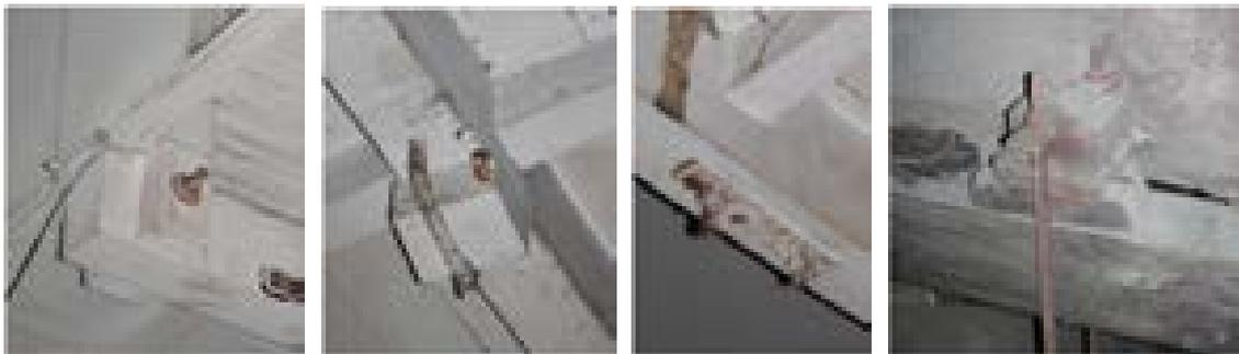
圖 3-24 台中市第四市場夾層樓板構造與屋架之連結方式
