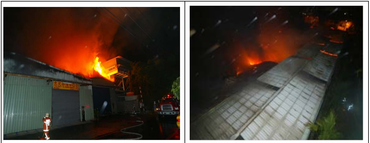
圖 17 連棟式鐵皮屋發生火災時燃燒情形
