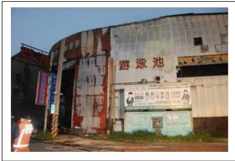
圖 3-17 屋外鐵皮明顯受燒變形氧化
