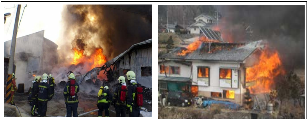
圖 18 燃燒至全盛期屋頂弓發生塌陷掉落之現象
