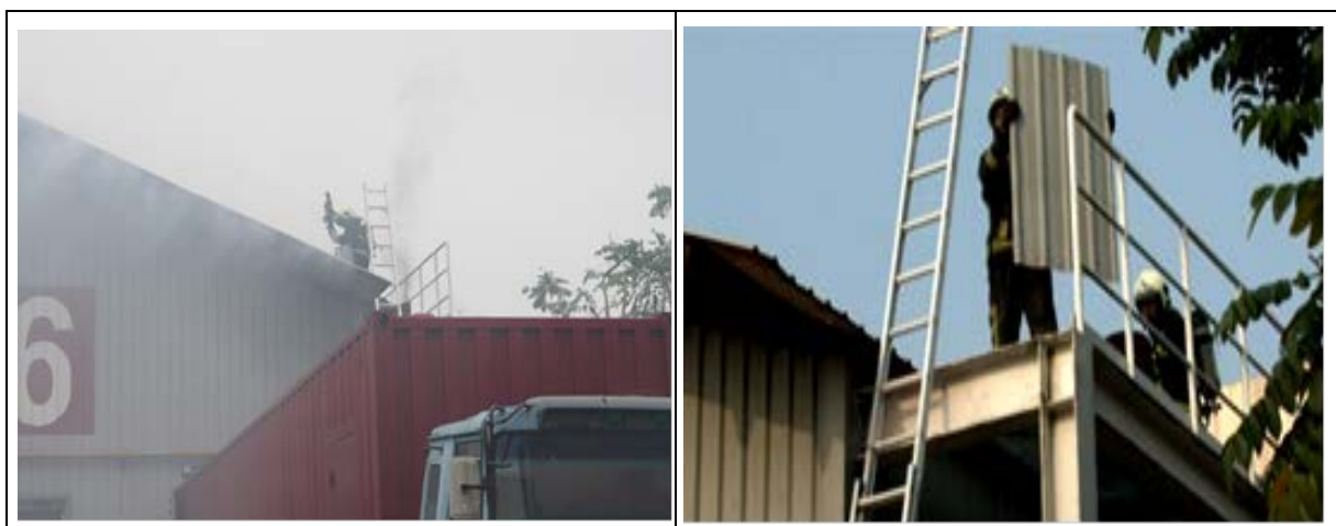
圖 19 通風排煙及屋頂破壞作業
