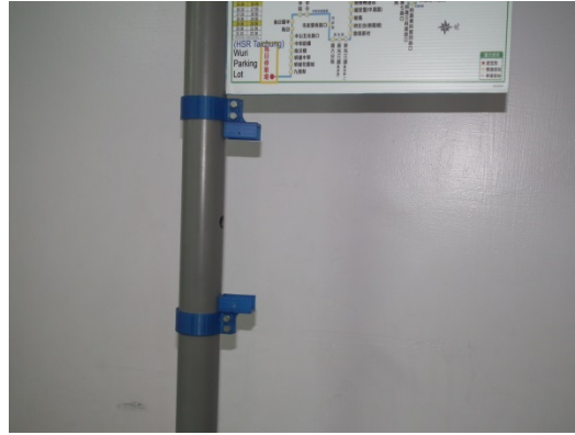
圖 5-12 電子紙支架安裝實況
