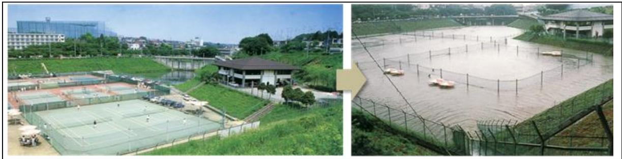
圖 3-2 多目標使用示意圖(鶴見川流域抑制設施霧丘調整池)
