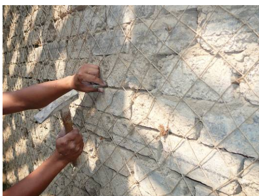
照片 6-1-3：土埆牆砌築後施作竹釘麻網
