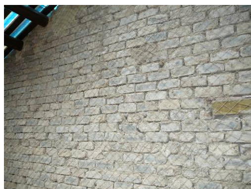
照片 6-1-4：土埆牆砌築完成
