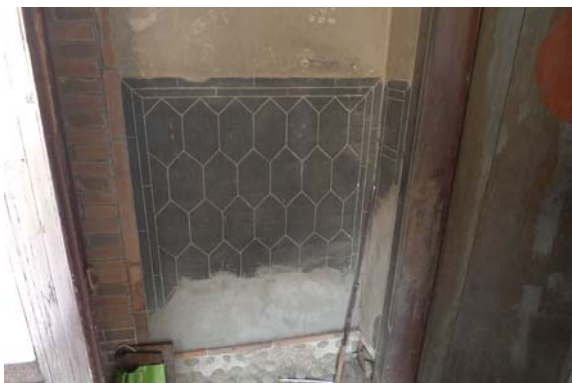
照片 3-3-13：門廳前簷牆內側裝飾粉刷（本研究攝）
