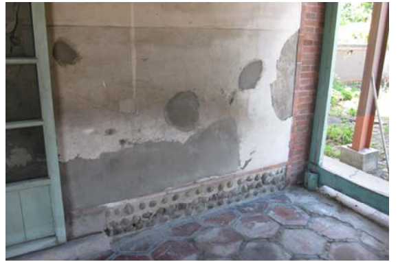
照片 3-3-18：門廳右隔斷牆基礎的止潮磚（本研究攝）
