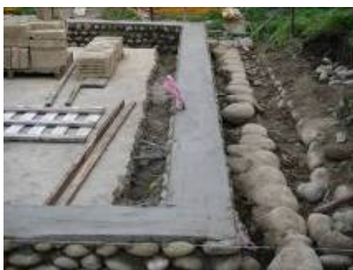
照片 6-1-15：卵石基礎及外側犬走完成
