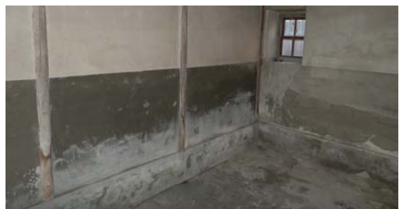
照片 3-4-6：屋架下方砌土塼磚牆（本研究攝）
