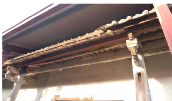
照片 3-4-16：廊柱與簷桁、壽樑組成狀況 (本研究攝)
