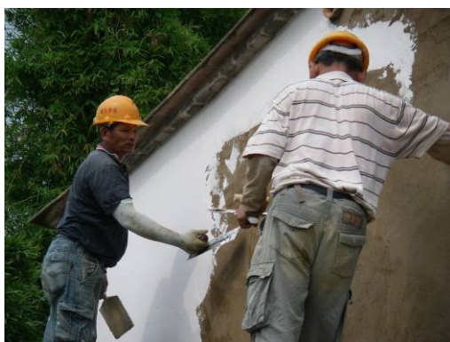
照片 6-1-7：面灰層施作
