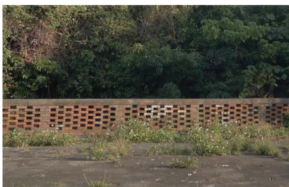
照片 3-5-9：內池磚組砌圍牆（本研究攝）
