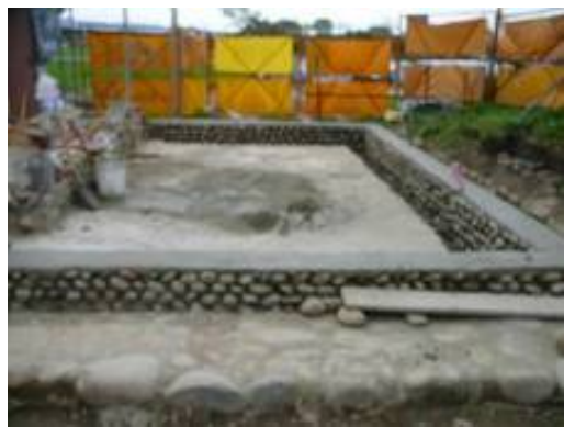
照片 6-1-14：基礎上方施作 RA 防水層
