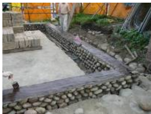
照片 6-1-16：基礎上方塗刷 RA 防水層
