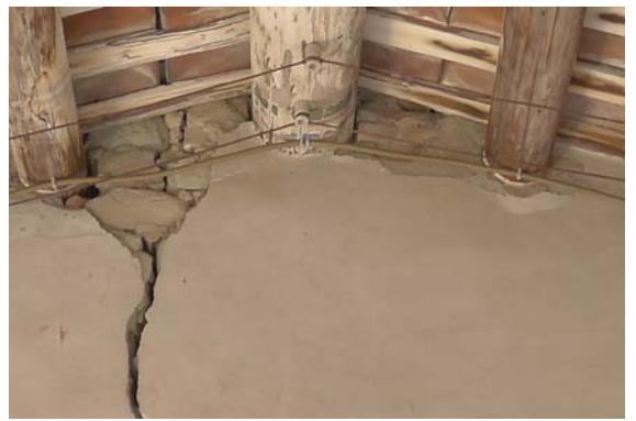
照片 3-3-20：屋頂滲水造成屋桁腐朽（本研究攝）
