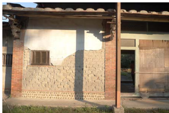
照片 3-3-12：門廳後簷牆土塊磚牆構造（本研究攝）
