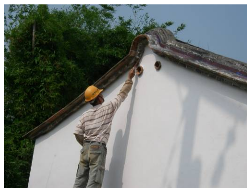
照片 6-1-8：面灰層施作完成
