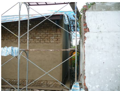
照片 6-1-5：外牆麻絨灰漿施作
