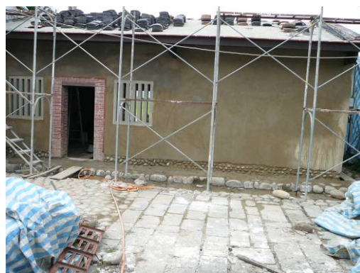
照片 6-1-6：外牆麻絨灰漿施作完成
