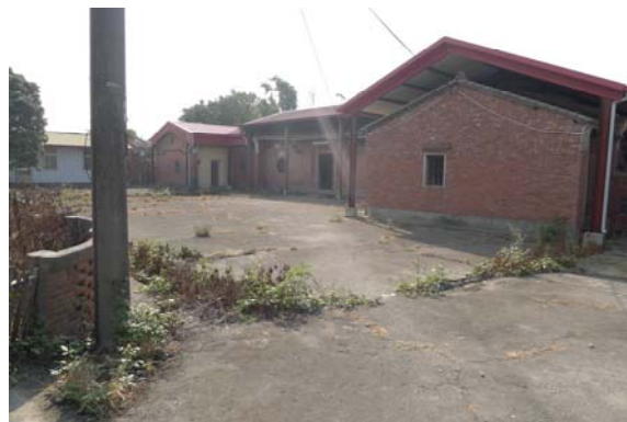
照片 3-5-4：前院排水溝（本研究攝）
