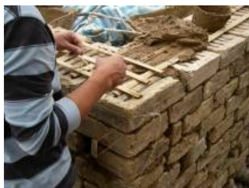
照片 6-1-18：每三層磚材間加設竹條補強
