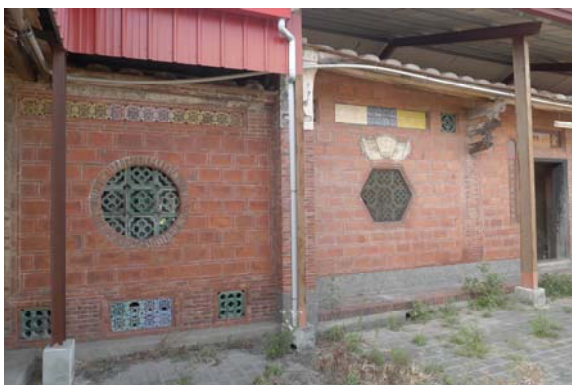
照片 3-3-11：門廳前簷牆斗砌磚牆構造（本研究攝）
