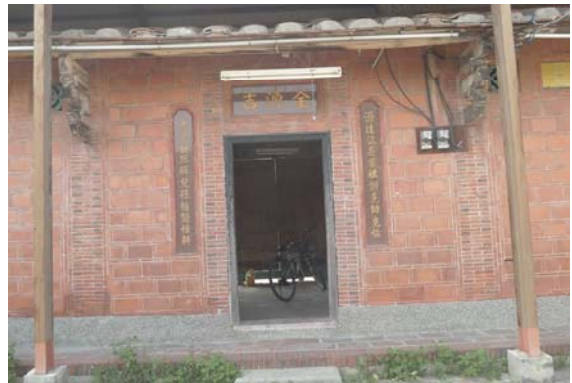
照片 3-4-4：門廳前簷牆斗砌磚造（本研究攝）
