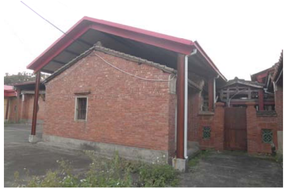
照片 3-3-16：左護龍末端山牆水磚構造（本研究攝）
