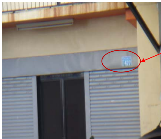
圖 4-6 運用街景圖檢視周遭景觀及現況使用情形
