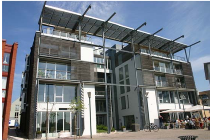
圖 3-4 西港區(Vastra Hamnen) 太陽能發電板融入建築設計
