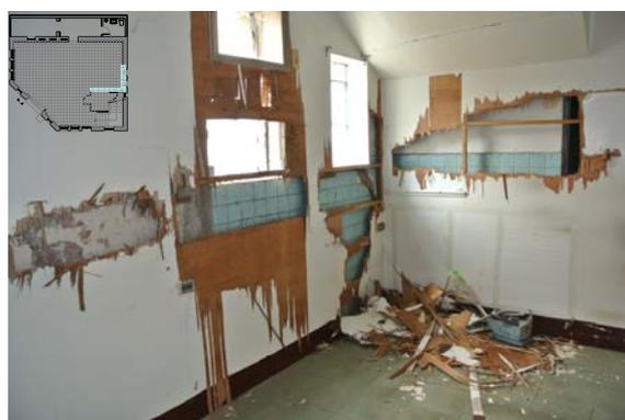
【圖 2-3-04】南側內牆原牆面貼覆磁磚
