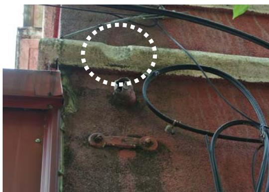
【圖 2-3-97】外牆飾帶凹陷以便落水管通過
