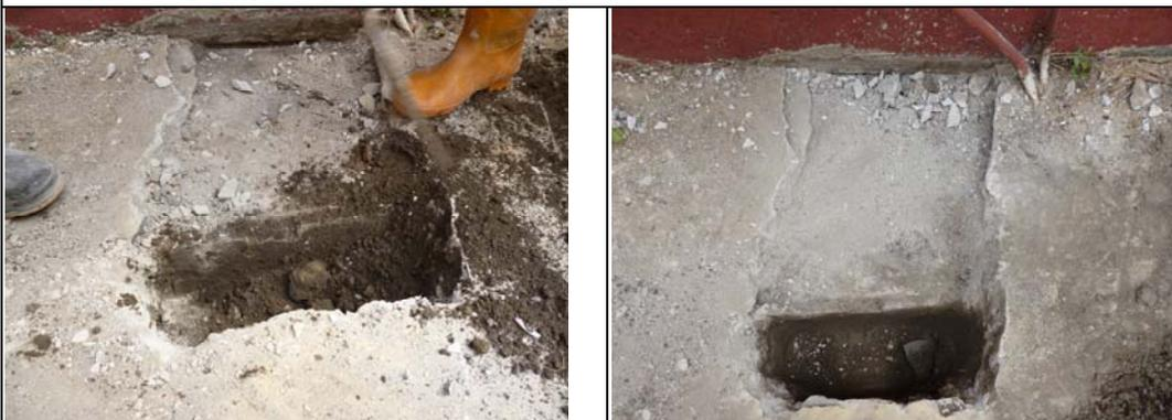
7.排水明溝以土填塞，溝底呈倒圓狀。
