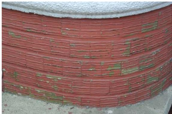
【圖 2-3-46】入口處之短方型溝面磚
