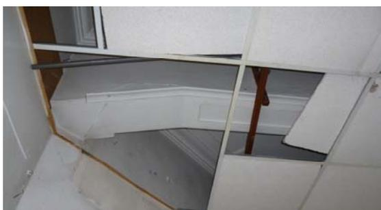
【圖 2-3-57】梁搭接處均向下放大斜切
