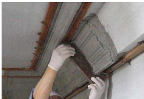
【圖 5-2-10】線角施作要求製作樣板
