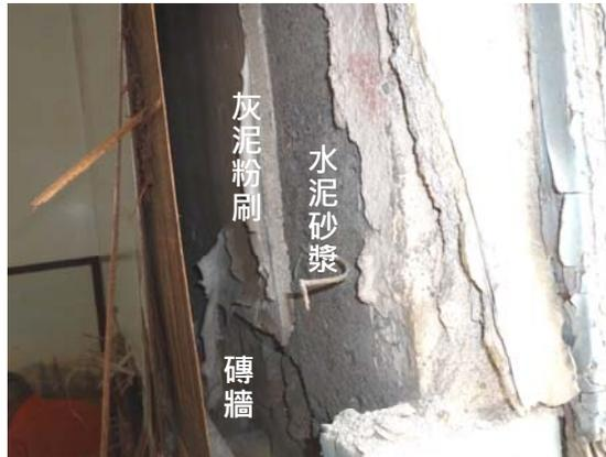
【圖 2-3-49】內牆原水泥砂漿與灰泥粉刷
