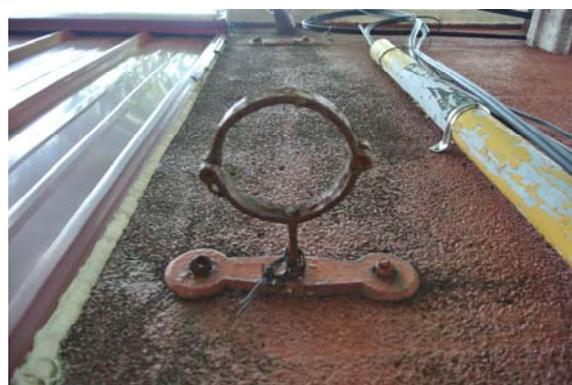
【圖 2-3-98】完整之原有落水管鐵件
