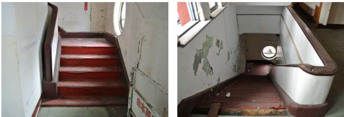
【圖 2-3-66】樓梯扶手亦為鐵筋混凝土造
