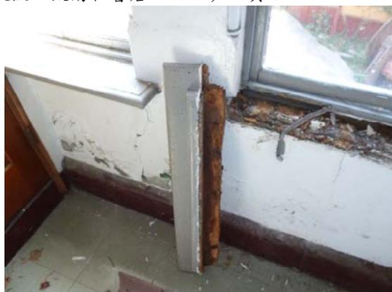
【圖 2-3-85】損壞掉落之窗臺構造
