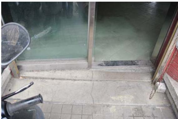
【圖 2-3-38】入口臺階採黃褐色磨石子
