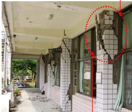
柱撓剪破壞程度示意
