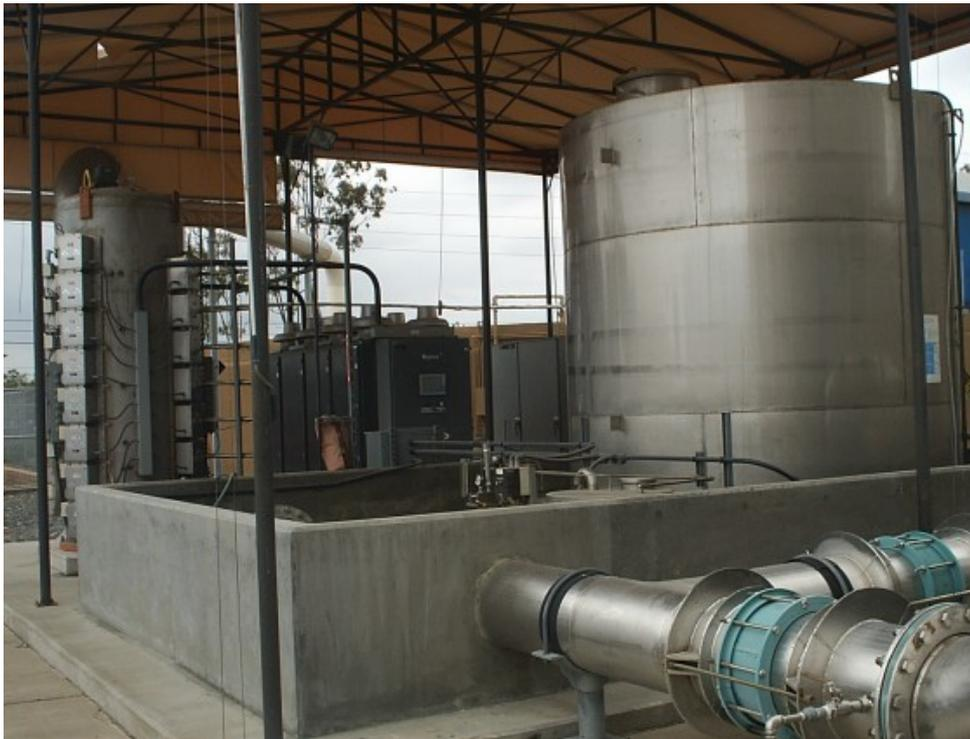
圖 2.3-5 高級氧化系統與過氧化氫槽體
