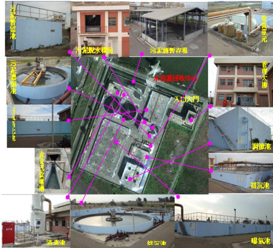
圖 3.2-26 廠區各段污水處理單元照片
