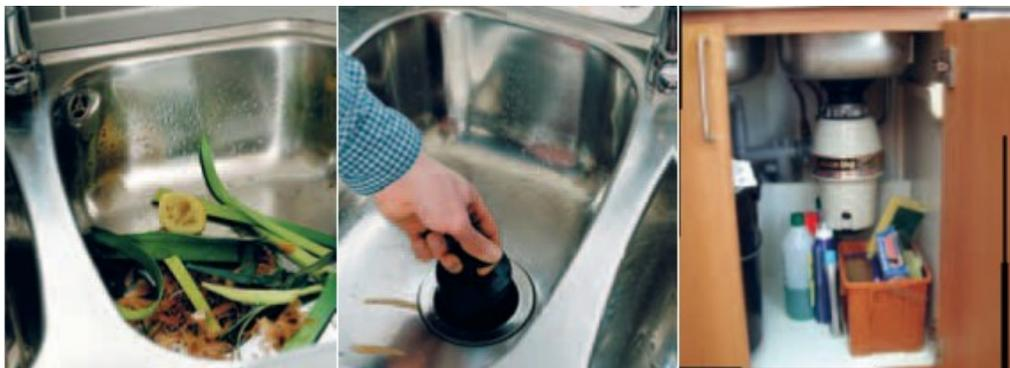
圖3-8 集中式真空廚餘專用槽系統
