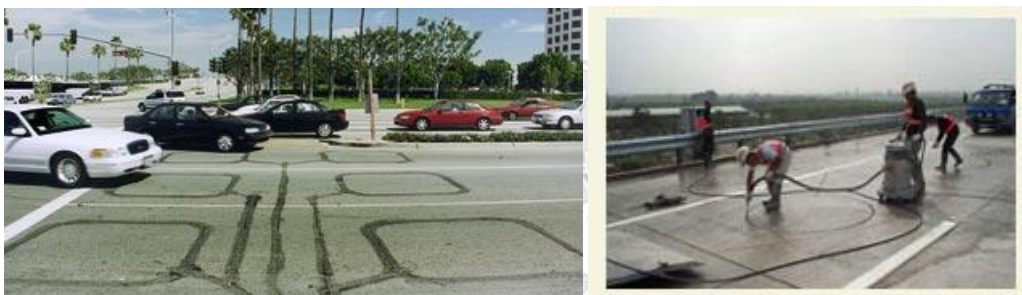
圖 2.2-1 環路線圈式車輛偵測器及佈設示意圖
