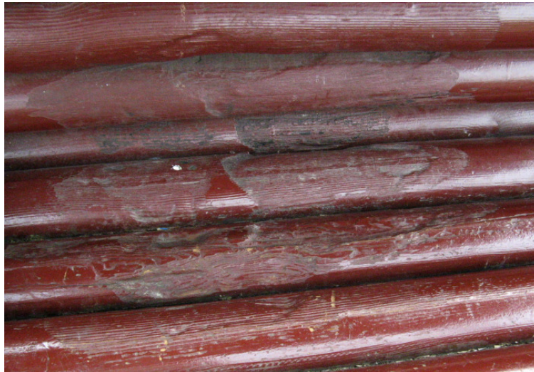
圖 4-7 座椅損壞現況
