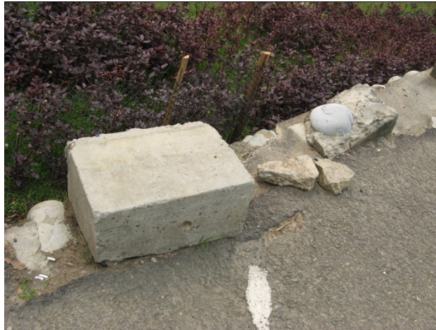
圖 4-5 斜坡道旁的水泥護欄
