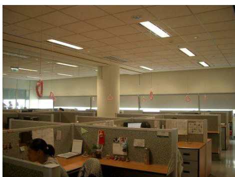
圖 4-20 低背景照度輔助以作業面檯燈照明設計 圖 4-21 照明控制
