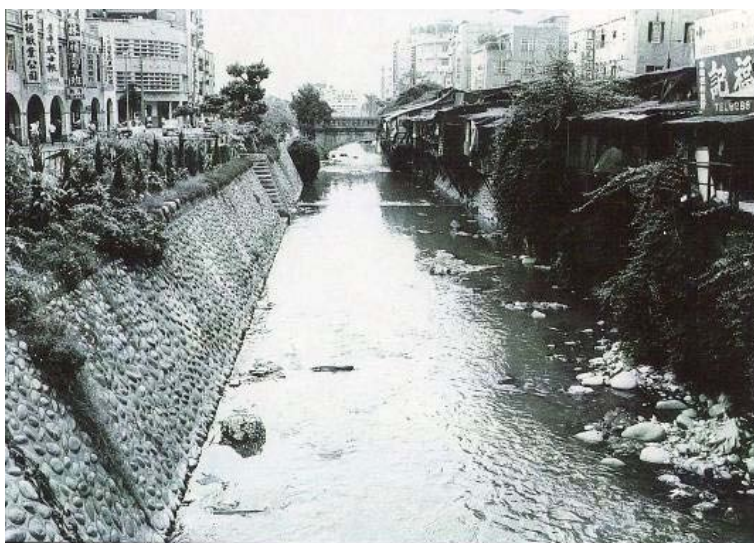
圖 5-16 同心花園第一階段（綠川東街）完工（1971 年） 380 說明：同心花園第一階段（綠川東街）完工後，與綠川西街的違建成為明顯對比，綠川西街違建於隔年拆除。
