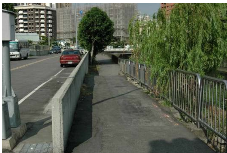
圖5—15 柳川旁樹義一巷之自行車道 378
