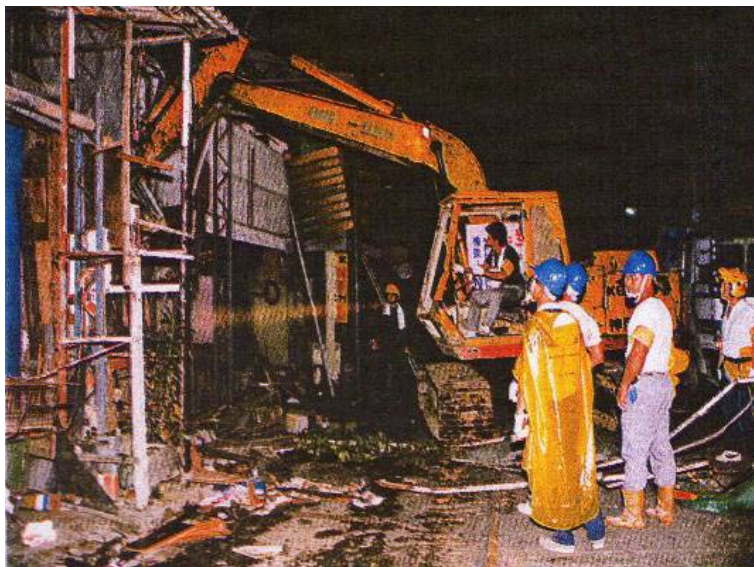
圖 4-22 市府出動多達 22 部之多的怪手，分成 10 組同時出動 328 說明：挖土機在嚴密的保護之下，緊隨著拆除人員駛入，拆除大隊人員穿著雨衣、頭戴鋼盔、全副武裝預防拆遷戶對其潑灑糞尿或石塊。竹木建材的違建對怪手無招架之力，僅 5 小時又 20 分即拆除完成。
