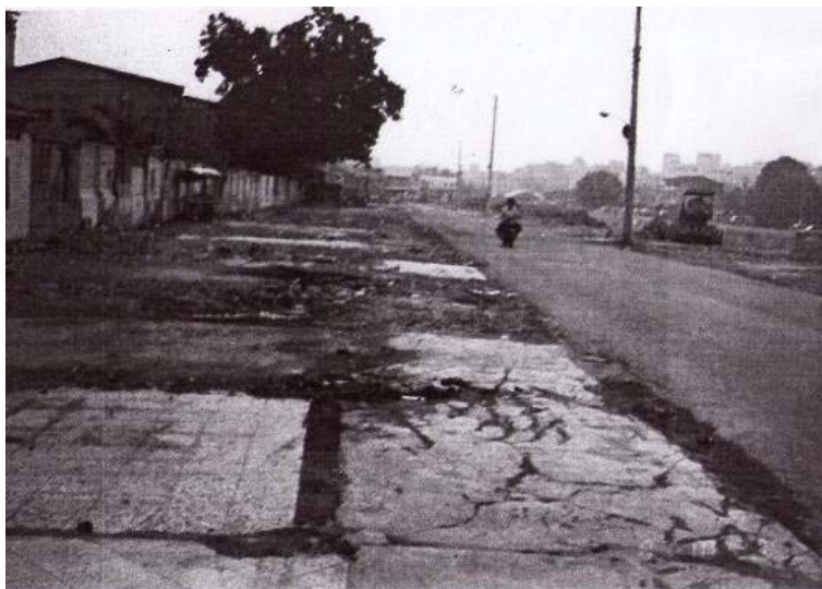
圖 4-23 柳川下游違建拆遷工作完成後景象 329
