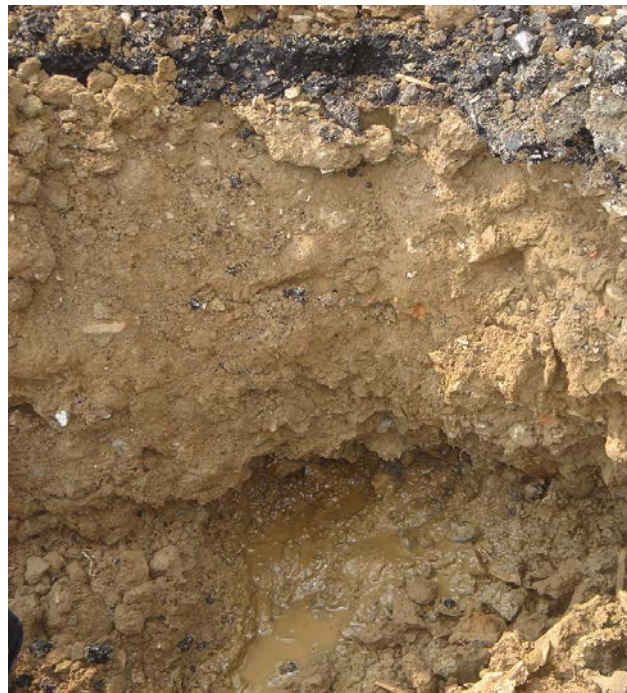
圖 3.8 景觀步道植栽區一側之鋪面結構系統中雨水入滲情形
