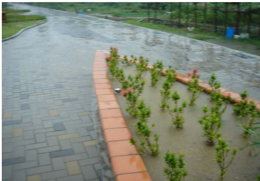
圖 3.5 雨水在景觀步道墊高之花圃匯集情形
