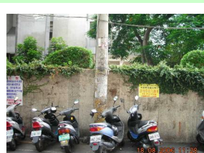
逢大圍牆邊北段(電線桿 及標示牌)
