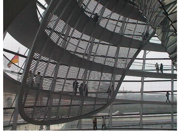
玻璃採光罩大量運用現代最新節能科技 大型智慧型遮陽板隨太陽角度自動變換方位
