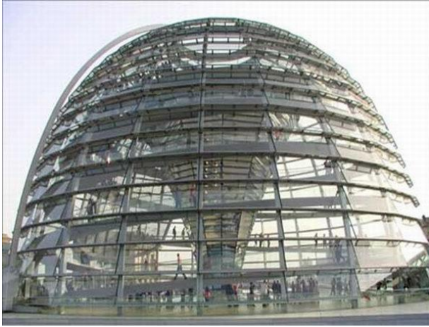
玻璃採光罩大量運用現代最新節能科技 大型智慧型遮陽板隨太陽角度自動變換方位
