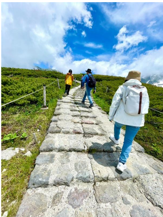
立山步道以混凝土膠結岩石鋪設
