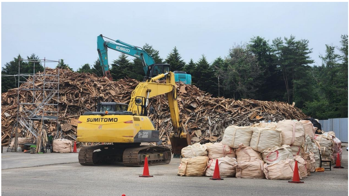
圖 10、中島廢棄物暫置場所現場作業情形
