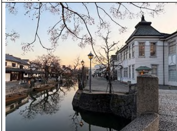
圖1-12：倉敷館原為「倉敷市役所」。1988 年轉型遊客服務中心。
