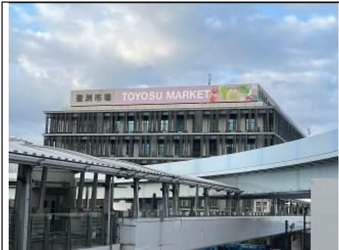
115.3.9 豊洲市場建物之一外貌
