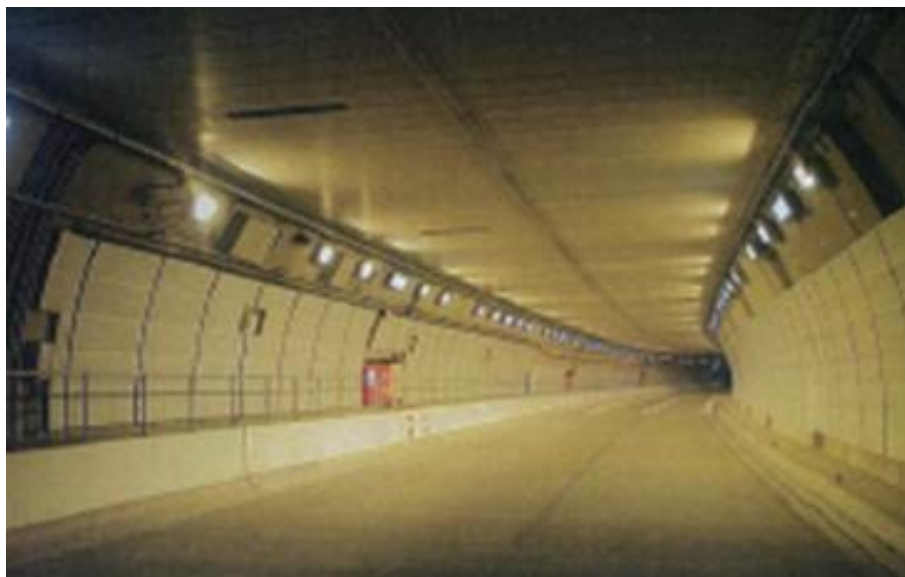
阪神高速公路的神戶山手線隧道神戶長田隧道照明設施
