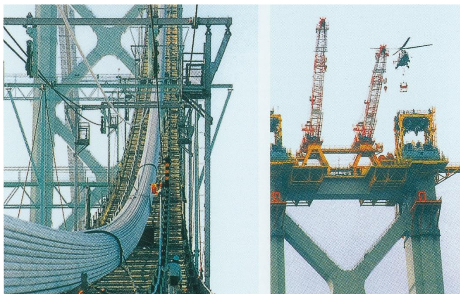
明石海峽大橋的主纜施工階段（右上可見直升機作業）
