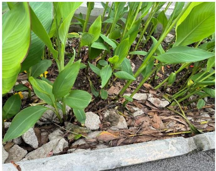
班嘉奇蒂森林公園(Benjakitti Forest Park)道路分隔島路凹陷型設計，並以路緣設置缺口回收路面雨水，槽化島內堆置建築物廢棄骨材，作為生物的棲息場所
