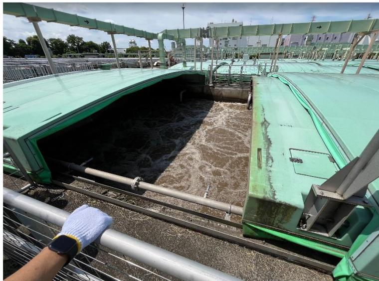
圖46 反應槽上加蓋可阻擋陽光避免微生物過量生長
