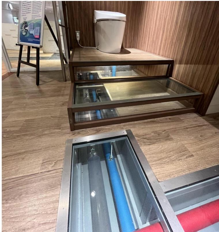
圖27 馬桶的冷水（藍）污水（透明管）
