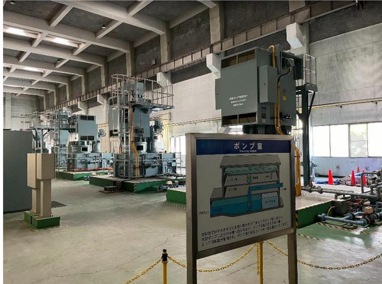
圖41 因合流制而設計之大型抽水機組
