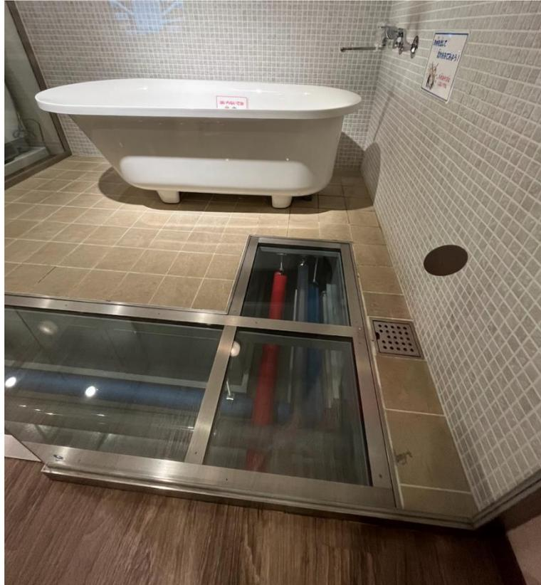
圖26 浴室的熱水（紅）冷水（藍）污水（透明管）
