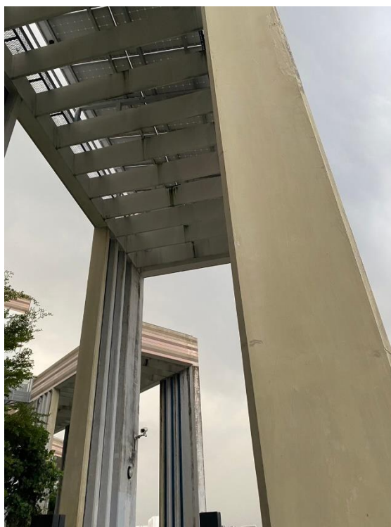
圖 27 SkyVille 組屋屋頂太陽能板
